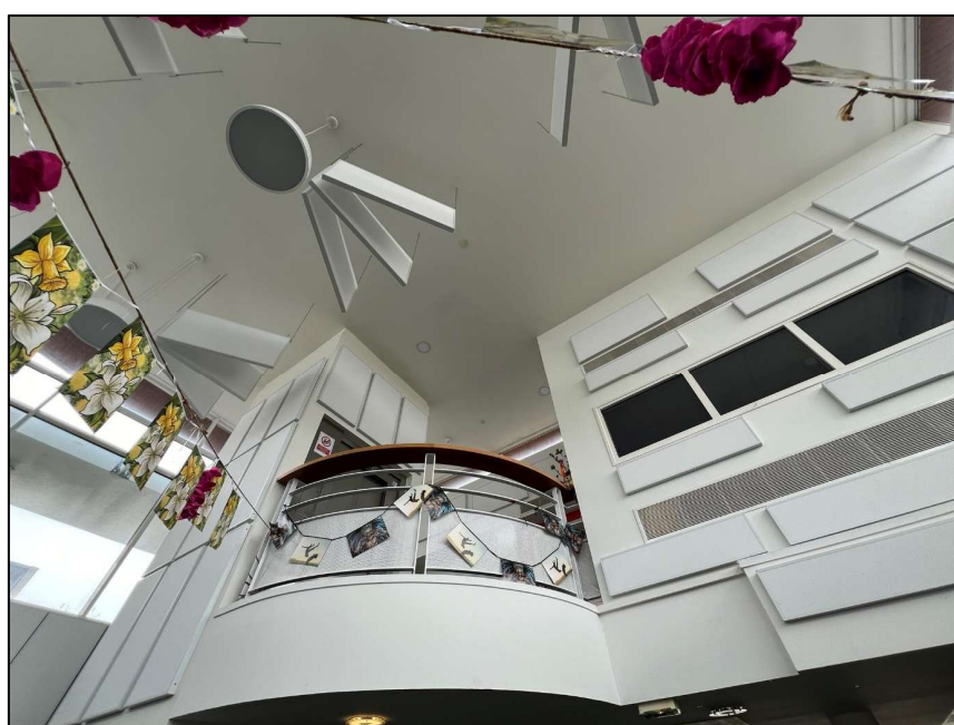
Figure 4 : photographie des éléments absorbants dans la salle de vie actuelle (dalles rectangulaires blanches).
